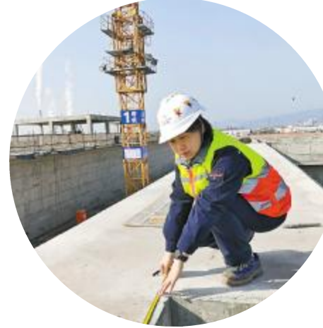
李姿娴现场复核废水站预留孔洞尺寸
